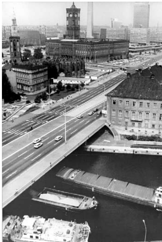
Die in den 1960er Jahren neu gebaute Mühlendammbrücke in Mitte. Auch in der DDR war seinerzeit die autogerechte Stadt der Maßstab aller Planungen. Das Bild zeigt die Brücke im Jahr 1978.
